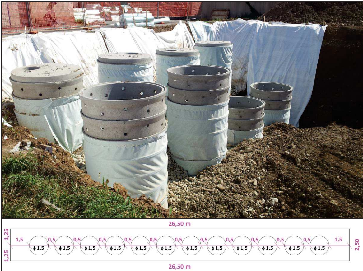
Figura 12: esempio di collocazione di pozzi perdenti in serie alloggiati in scavo non cilindrico (nel caso dell'immagine rettangolare, con due serie parallele da quattro pozzi cadauna; nel caso in progetto UNA serie in scavo rettangolare di lati 26,5 x 2,50 m, come da schema in pianta sottostante all'immagine)
